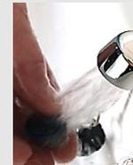
4. Replacer le filtre dans le mousseur.
