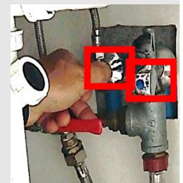
12. Mettre la tête de robinet en place et la serrer avec une clé à molette.
